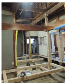
限界耐力計算による耐震改修工事
