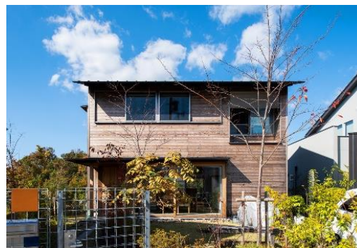
施工例：里山住宅博ヴァンガードハウス
